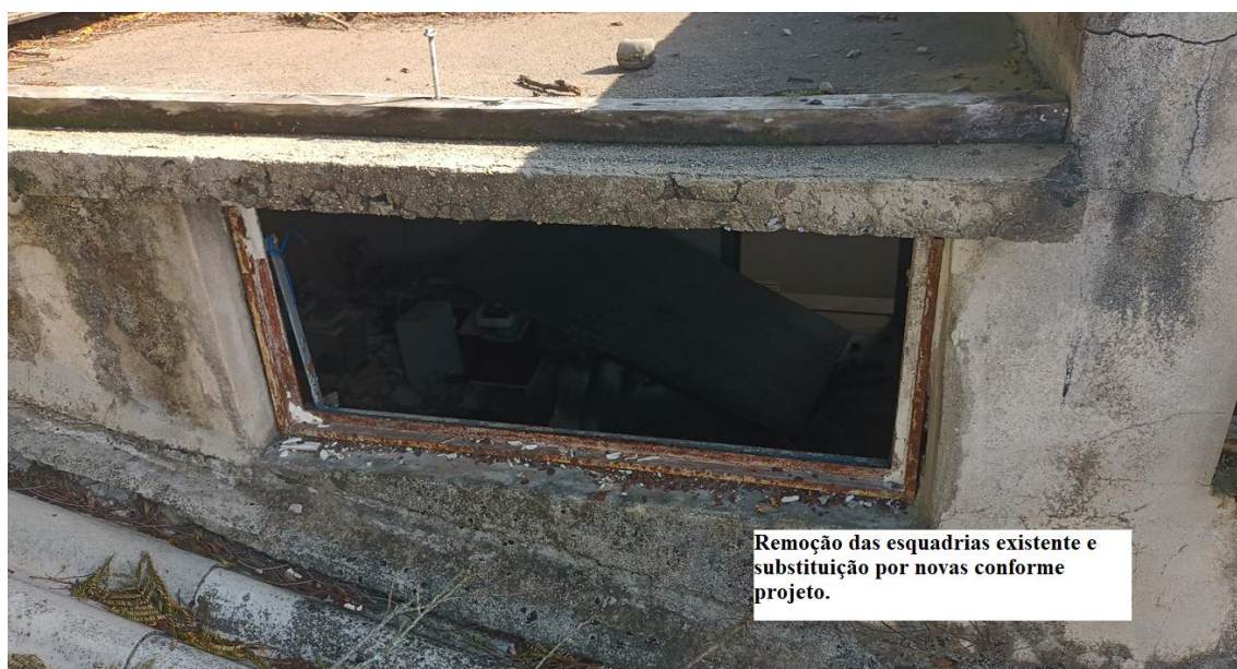
Figura 6 - Remoção das esquadrias existentes e substituição por novas conforme projeto
