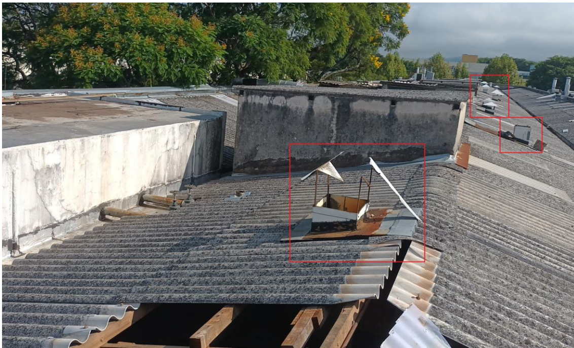
Figura 12 – Chapa de aço galvanizado no sistema de exaustão a ser substituído.
