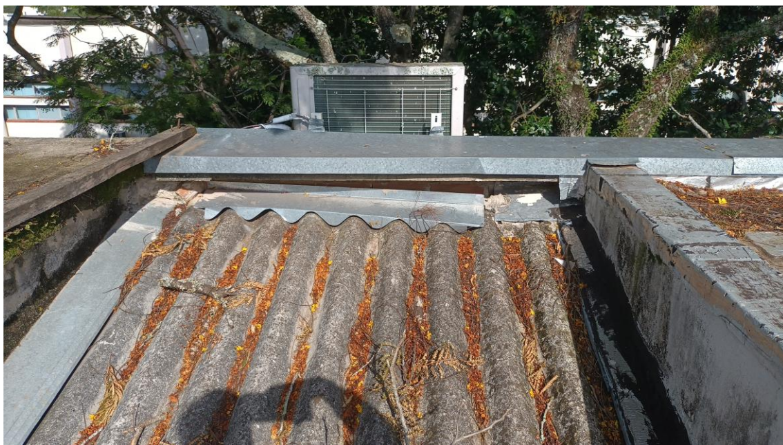
Figura 9 – Capeamento da platibanda e rufos a serem substituídos.
