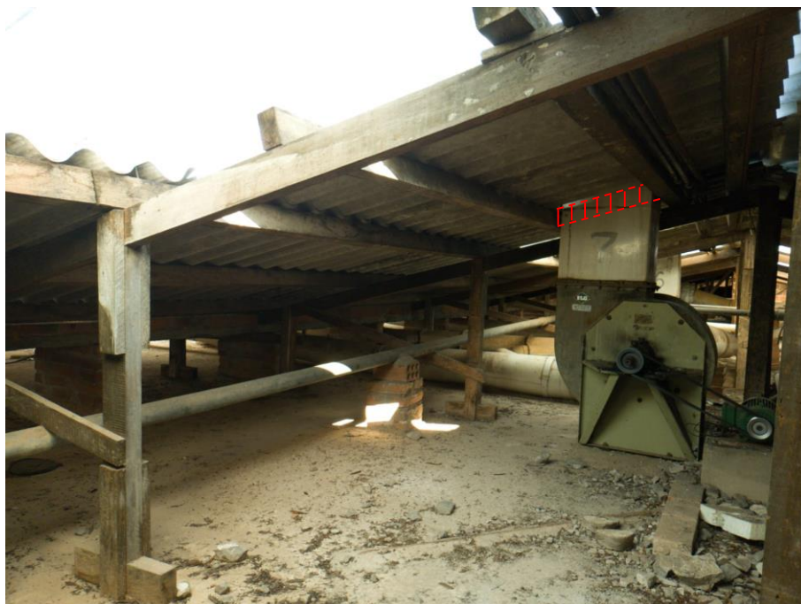
Figura 15 – Travamento em caibro de madeira 6 x 12 a ser executado
