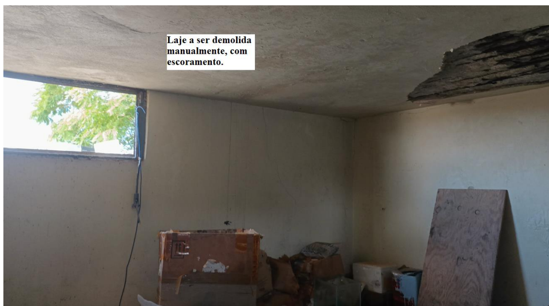
Figura 7 – Laje de concreto a ser demolida para execução de nova laje em pré-moldada.
