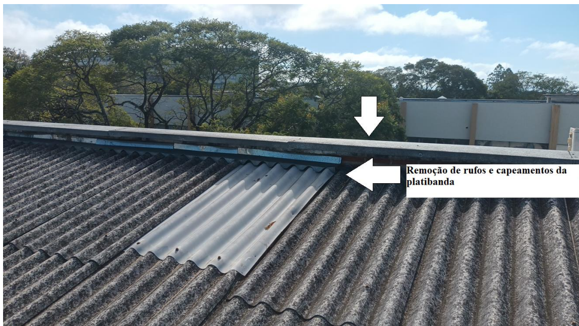
Figura 2 - Remoção de rufos e capeamentos da platibanda
