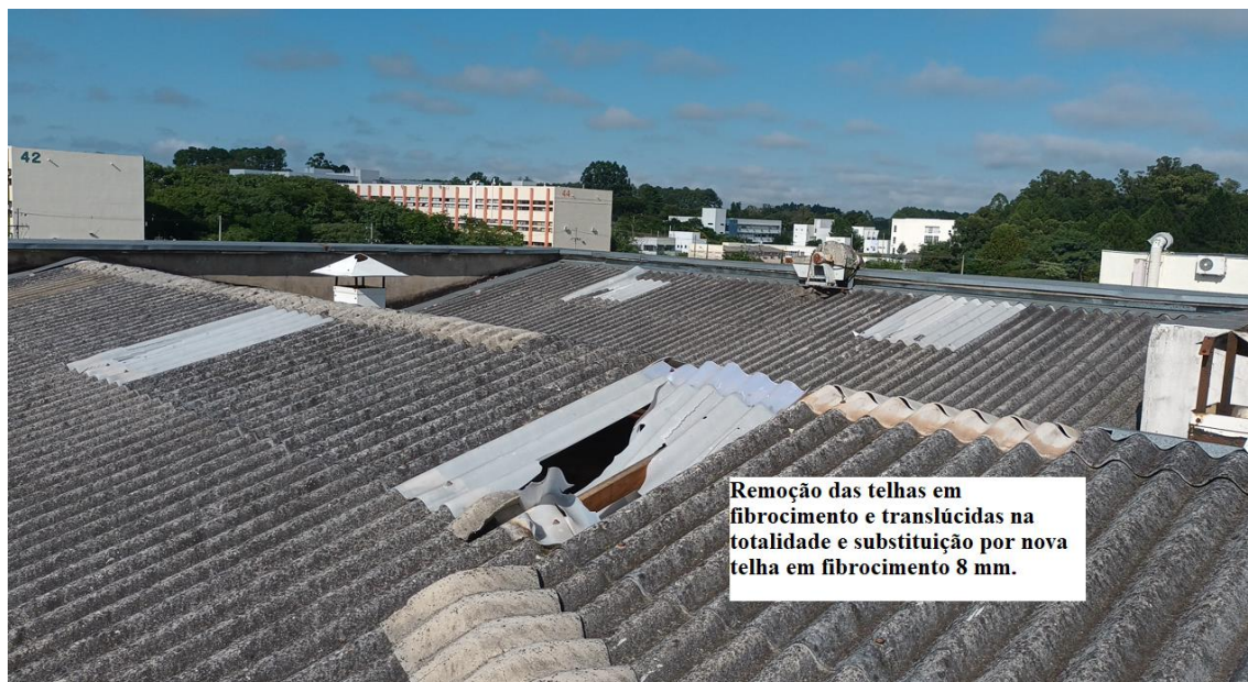
Figura 1 - Remoção das telhas de fibrocimento e translúcidas e substituição por telha em fibrocimento 8 mm.
