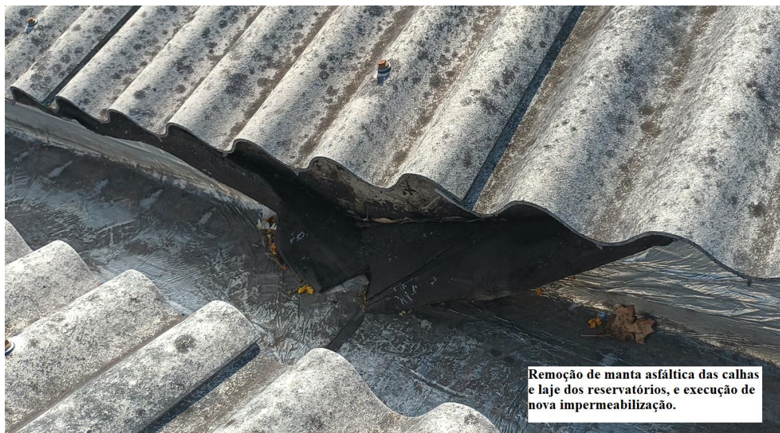
Figura 4 - Remoção da manta asfáltica das calhas e laje dos reservatórios e execução de nova impermeabilização.
