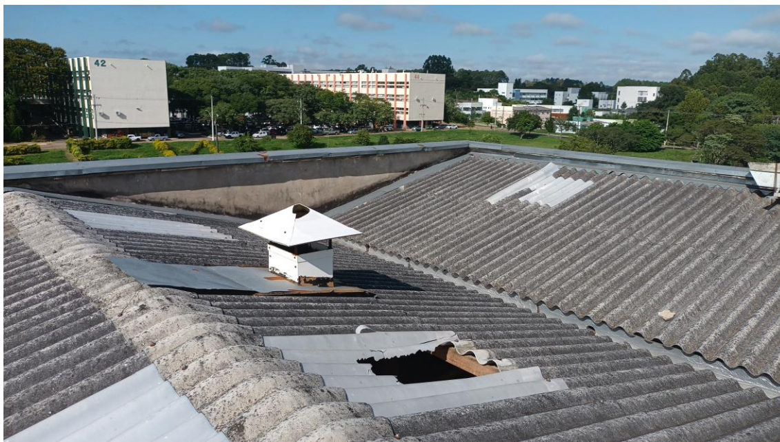
Figura 11 – Chapa de aço galvanizado no sistema de exaustão a ser substituído.
