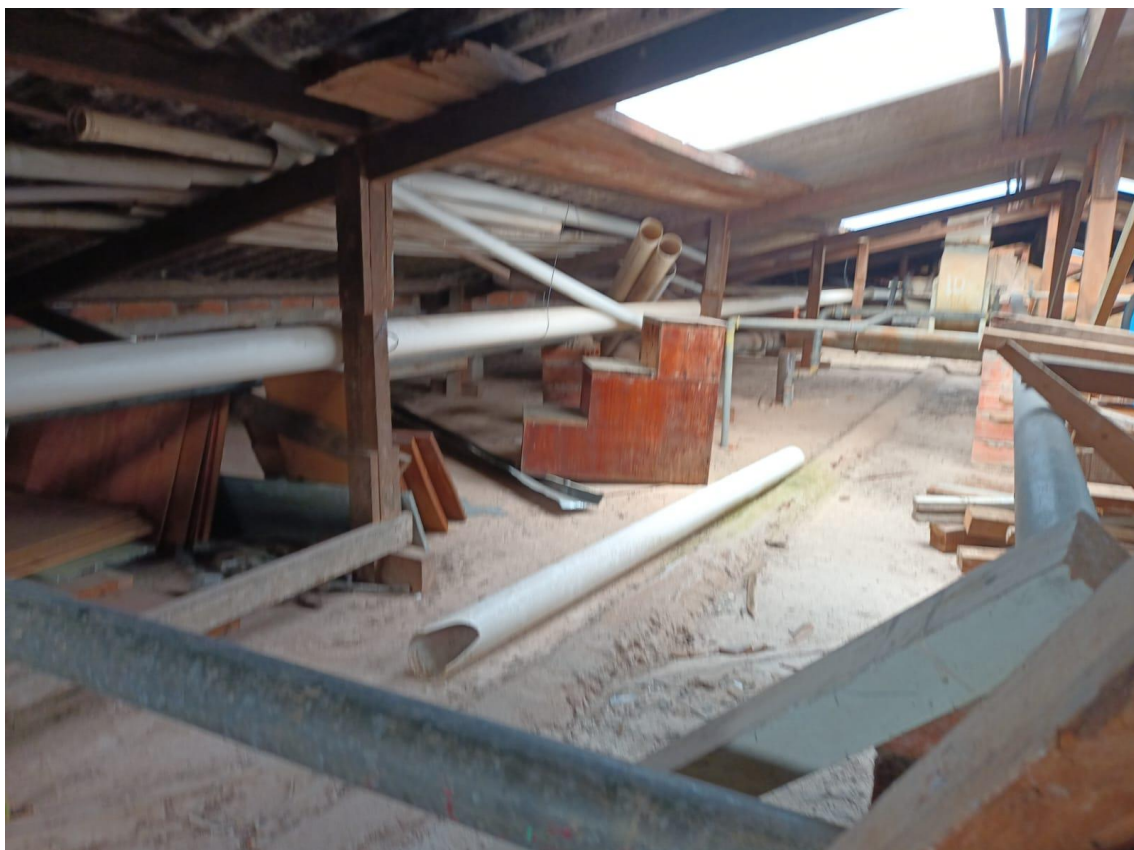
Figura 8 – Entulho entre laje e cobertura deve ser descartado para aterro licenciado.
