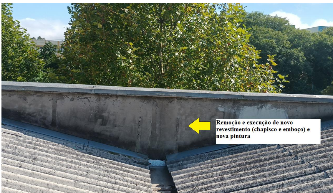
Figura 3 - Remoção e execução de novo revestimento (chapisco e emboço), pintura e execução de capa muro em chapa de aço galvanizada nº 26.
